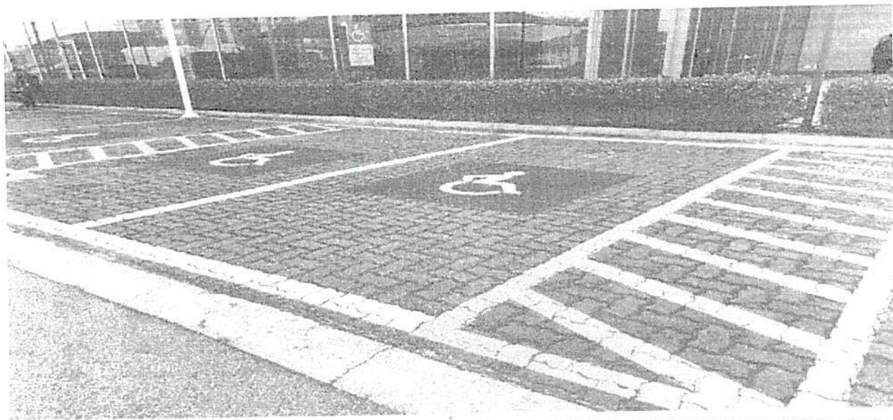
Fig. 5 - Vagas destinadas a pessoas com deficiência
